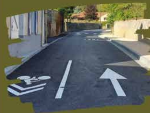
Réalisation des travaux rue de la gare
